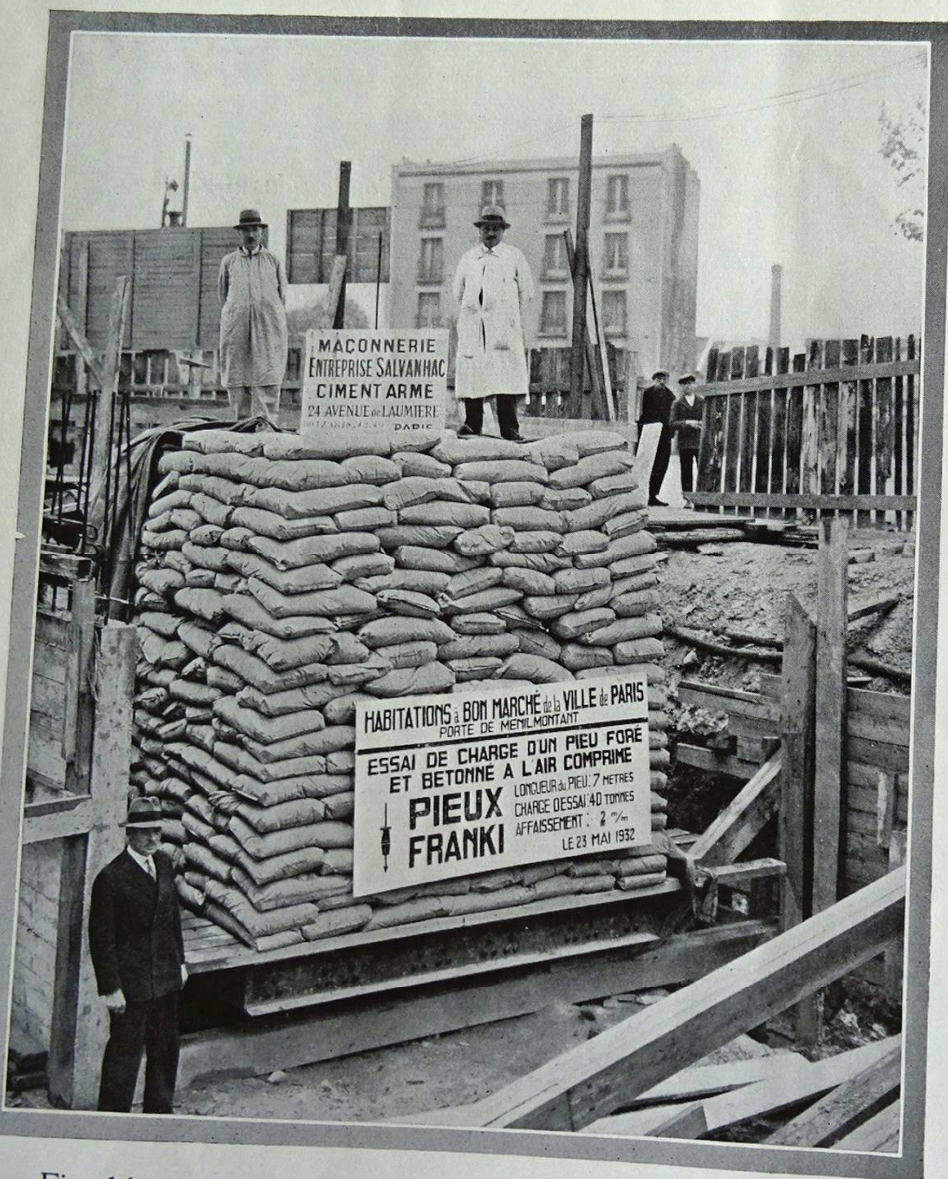
Fig. 16. — Habitations à bon marché de la Ville de Paris, porte de Ménilmontant. Essai de charge d'un pieu Foré. Longueur du pieu : 7 m. Charge d'essai : 40 tonnes. Affaissement : 2 mm.
