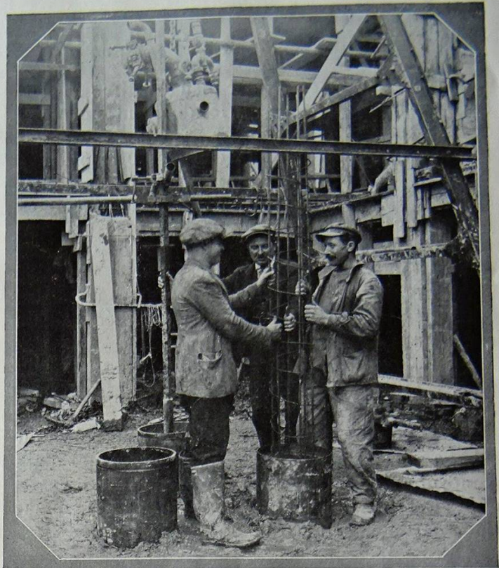
Fig. 8. — Le forage est terminé. Introduction de l'armature dans le tubage. Ces armatures se composent de 6 barres d'acier de 16 mm. réunies par des spires de 10 mm. au pas de 15 cm.
