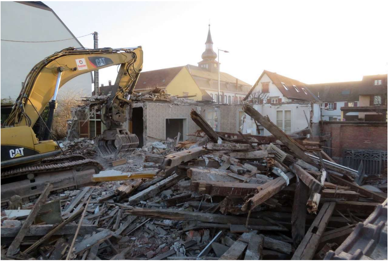
Illustration : Démolition de la maison du jardinier seigneurial à Brumath en 2022.
