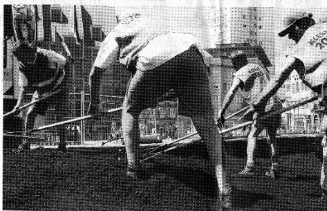
Sur le parquet de béton a été étalé du terreau pour les plantations. (Photo DNA - Michel Frison)
