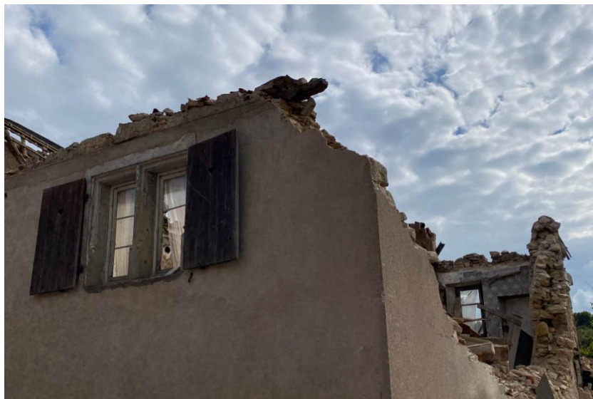
Un des encadrements sculpté Renaissance en attente d'être broyé par la pelle mécanique !
